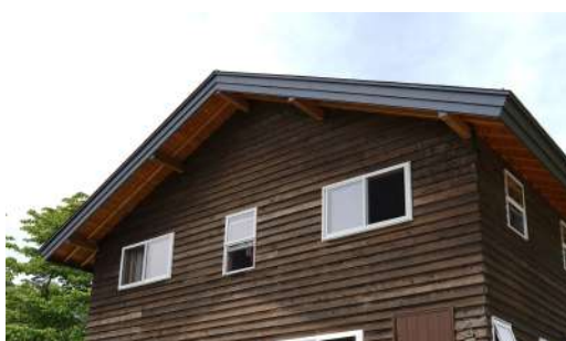
破風鼻隠し 鋼板仕上げ
